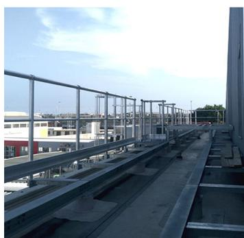
Parapetto con fissaggio su supporto
